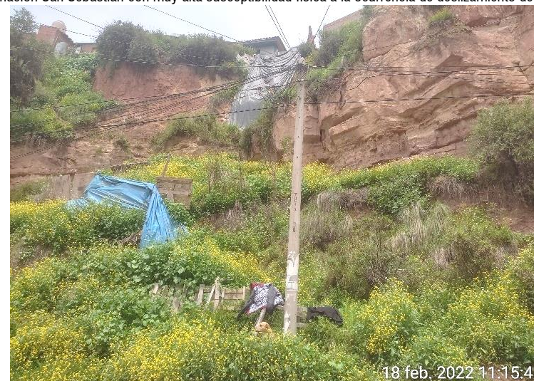
Imagen N° 42: Ladera de quebrada con inclinación vertical y compuesta por material de deatomea de la formación San Sebastián con muy alta susceptibilidad física a la ocurrencia de deslizamiento de suelos
