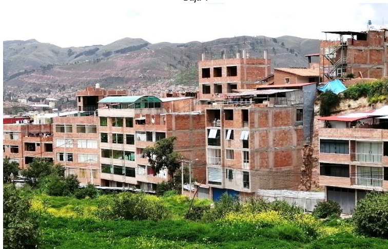
Imagen N° 90: Edificaciones de 5 niveles ubicadas en el sector denominado "Uñancayra Baja".
