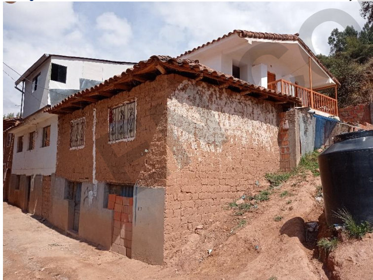
Imagen N° 91: Edificación de 2 niveles ubicado en el sector denominado "26 de mayo"
