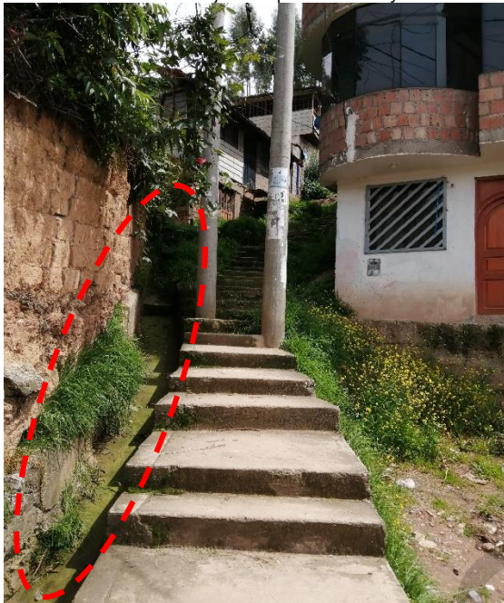
Imagen N° 62: Inicio del canal de drenaje de la quebrada Uñakayra en el ámbito de estudio.
