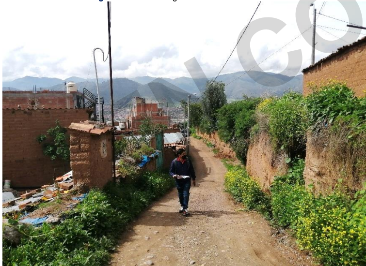
Imagen N° 72: "Prolongación Rumiñan" vía afirmada.
