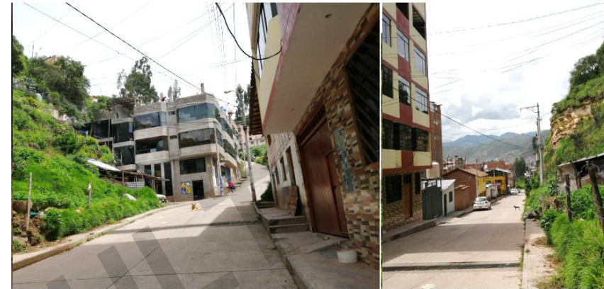
Imagen N° 102: Sumideros colectores ubicados cada 100 m aproximadamente en calle Juan Velasco Alvarado.
